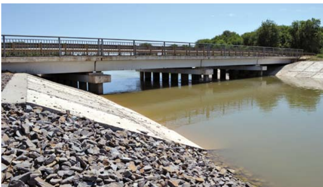
Отремонтированный участок Пролетарского магистрального канала
